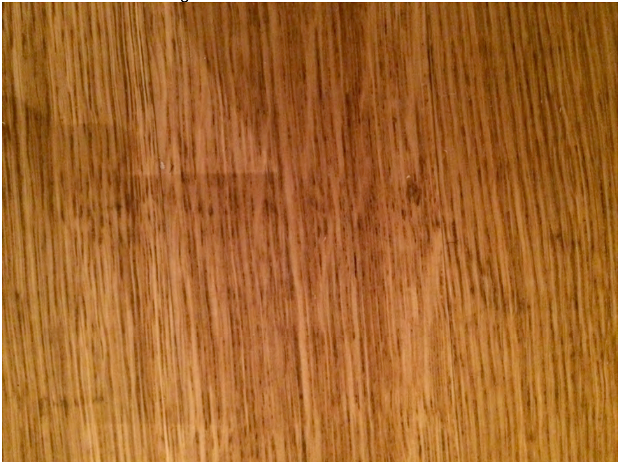
Starke Verschmutzung der Poren
